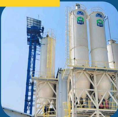
Berfungsi untuk memaksimalkan pengosongan cairan atau padatan secara gravitasi. Sangat ideal untuk bahan yang kental, berbusa, atau mengendap.
